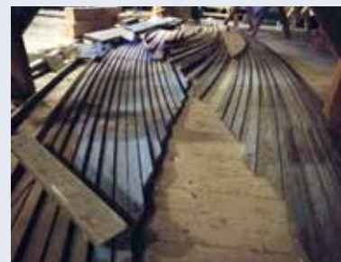
Oude latten zorgvuldig gedemonteerd en gedroogd. Na het verwijderen van spijkers, schaven en schuren weer klaar voor hergebruik.
